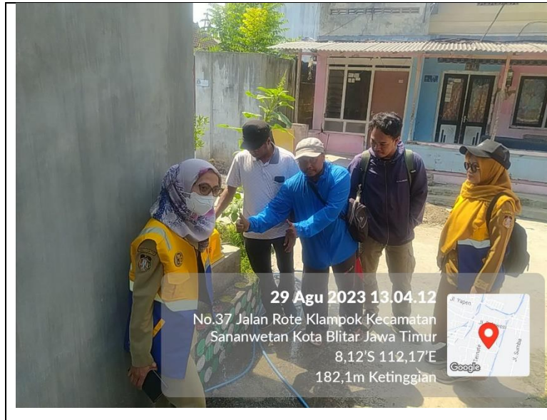
Gambar 3.3.3 Penambahan Sambungan Rumah SPAM di Kelurahan Klampok
