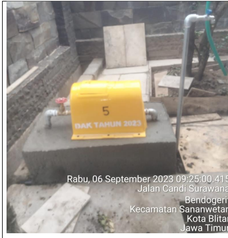
Gambar 3.3.1 Penambahan Sambungan Rumah SPAM di Kelurahan Bendogerit
