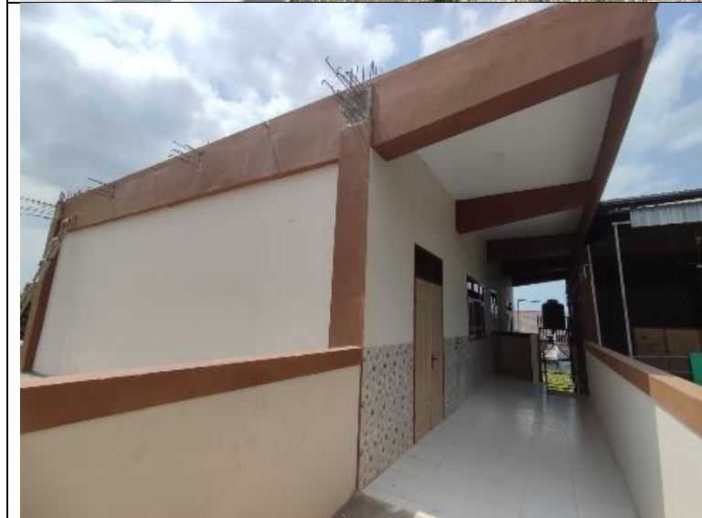
Gambar 3.1.15, Pembangunan RKB SMP Alam Al Ghifari
