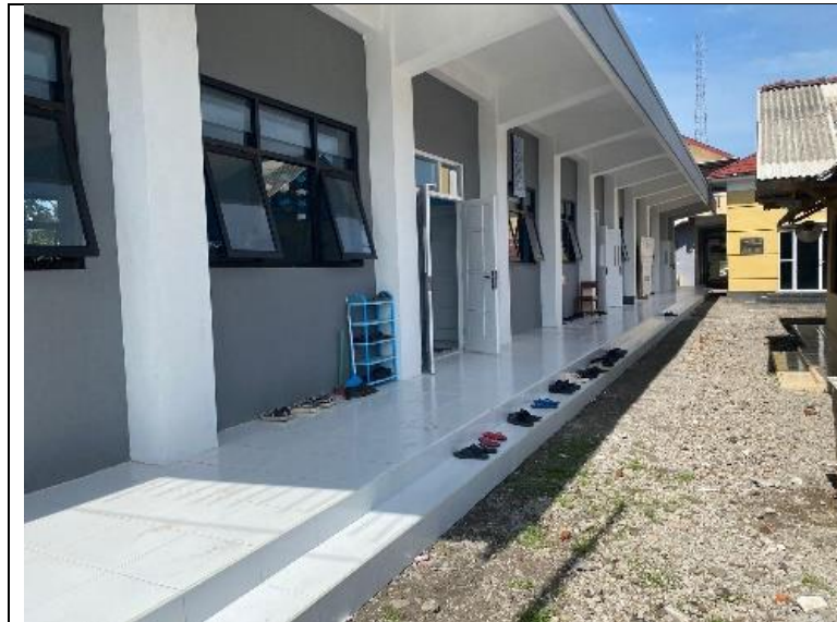
Gambar 3.1.14, Pembangunan RKB SMP Muhammadiyah 2
