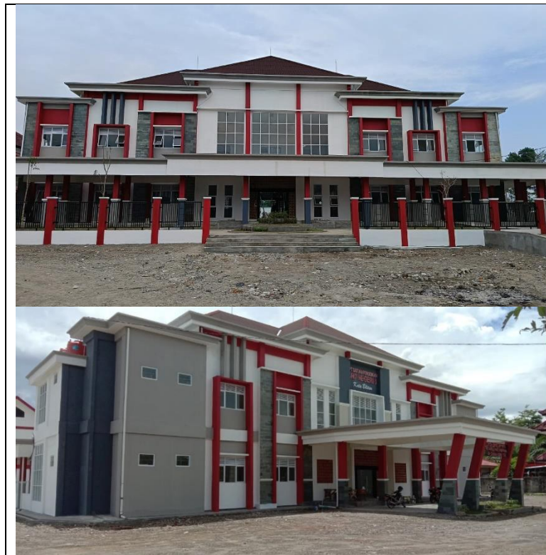
Gambar 3.1.13, Pembangunan SMPN 6 Kota Blitar
