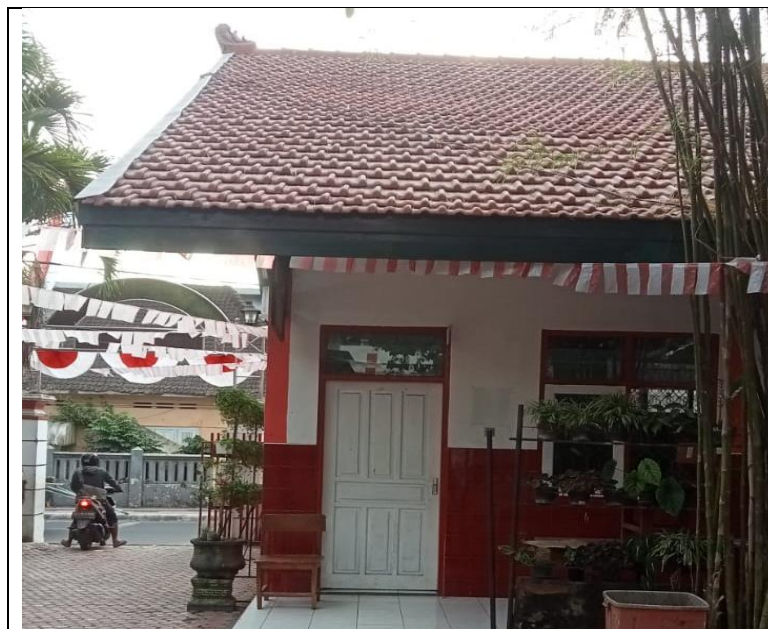
Gambar 3.1.10. Rehabiliatsi Ruang Kelas
