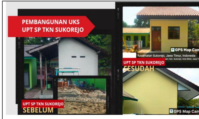
Gambar 3.1.2. Pembangunan UKS UPT SP TKN SUKOREJO
