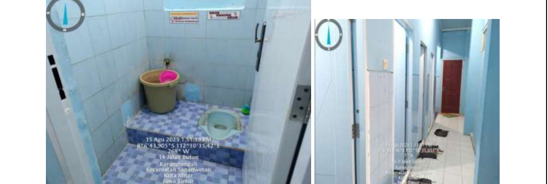
Gambar 4.1.19. Rehabilitasi toilet SDN 2 Karangtengah
