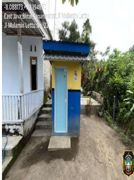
Gambar 4.3.3. Pembangunan Tangki Septik Individual Beserta Bilik Kamar Mandi di Kelurahan Gedog.
