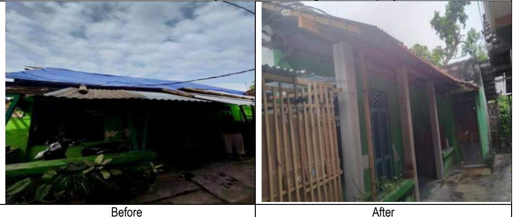
Gambar 3.4.5. Rehabilitasi Rumah akibat Hujan Deras disertai Angin di Kel. Kepanjenkidul
