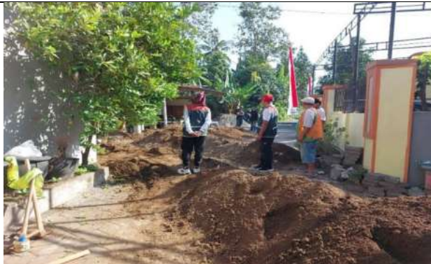
Gambar 4.3.4. Penambahan Sambungan Rumah (SR) dan Bangunan Pelengkap IPAL di Kelurahan Kauman.
