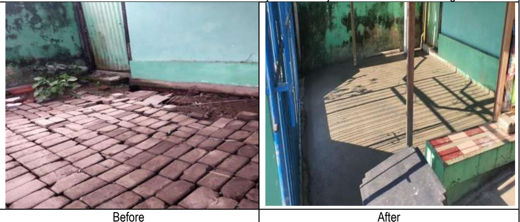
Gambar 4.4.4. Rehabilitasi Rumah akibat Terkena Banjir karena Hujan Deras di Kel. Rembang
