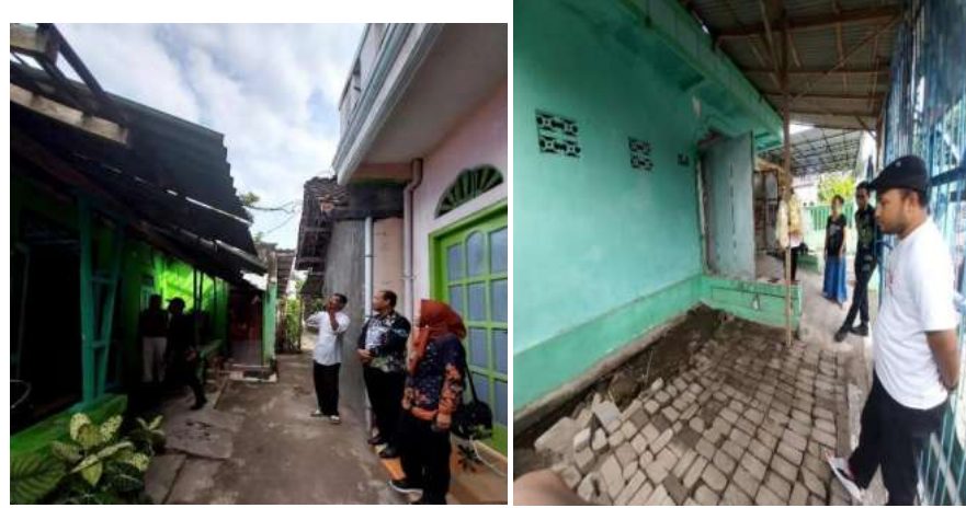
Gambar 4.4.3. Verifikasi dan Survey Lapangan Rumah Terdampak Bencana
