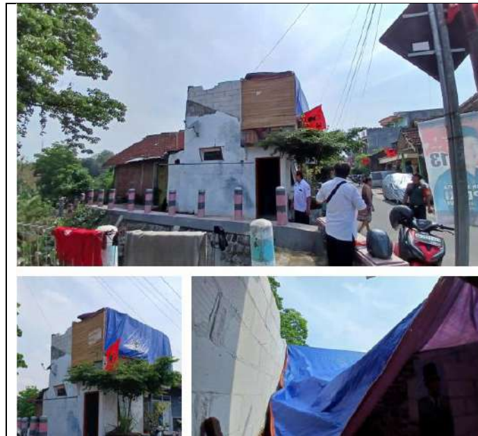
Gambar 3.4.3. Verifikasi dan Survey Lapangan Rumah Terdampak Bencana
