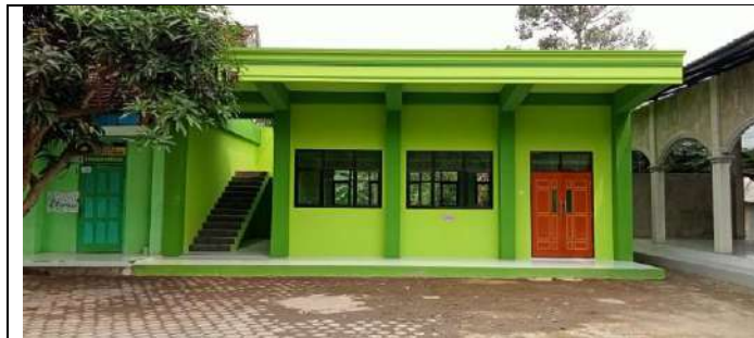
Gambar 3.1.6. Pembangunan Ruang Lab.Komputer dan Ruang Guru SD Islam Maarif
