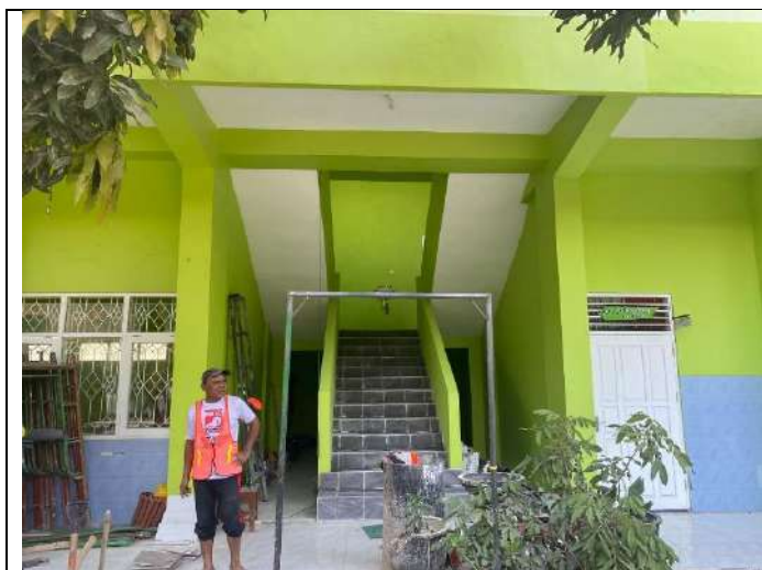
Gambar 3.1.5. Pembangunan Ruang Lab.Komputer dan Rehab Toilet SDN Blitar
