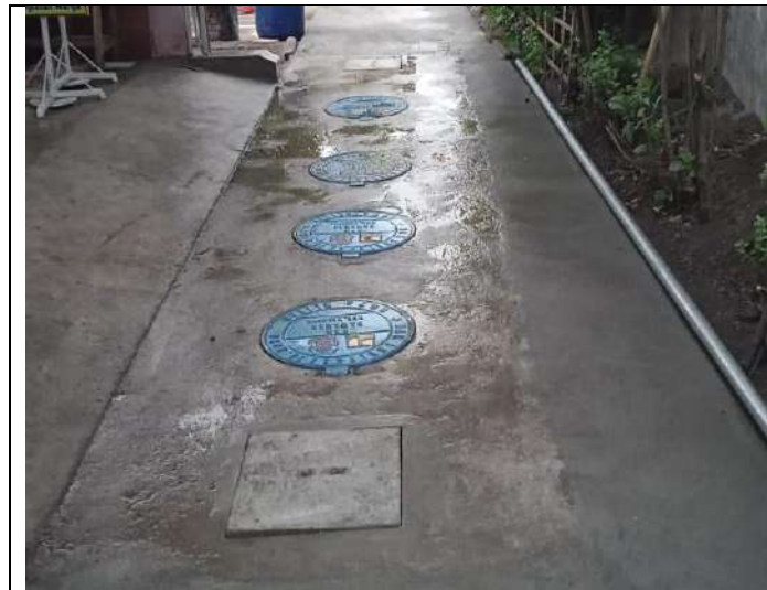
Gambar 3.3.6. Pembangunan tangki septik komunal (5-10 KK) Kelurahan Klampok
